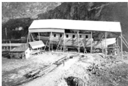
«Suldalsporten» under bygging på Vekamoen 1938/1939
